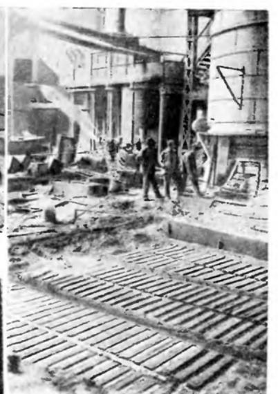
Пробивка спускной формы чугуна перед выпуском.
