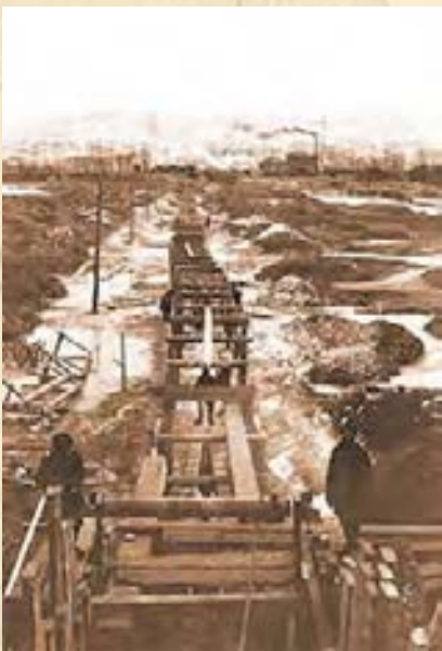
Прокладка водопроводных труб через протоку с о. Посадский к электростанции, г. Красноярск, 1913 г.
