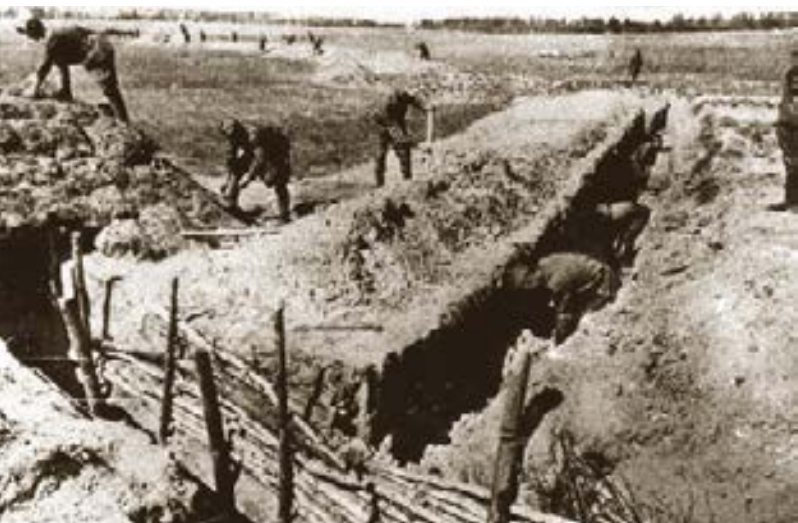
Строительство опорного пункта обороны
