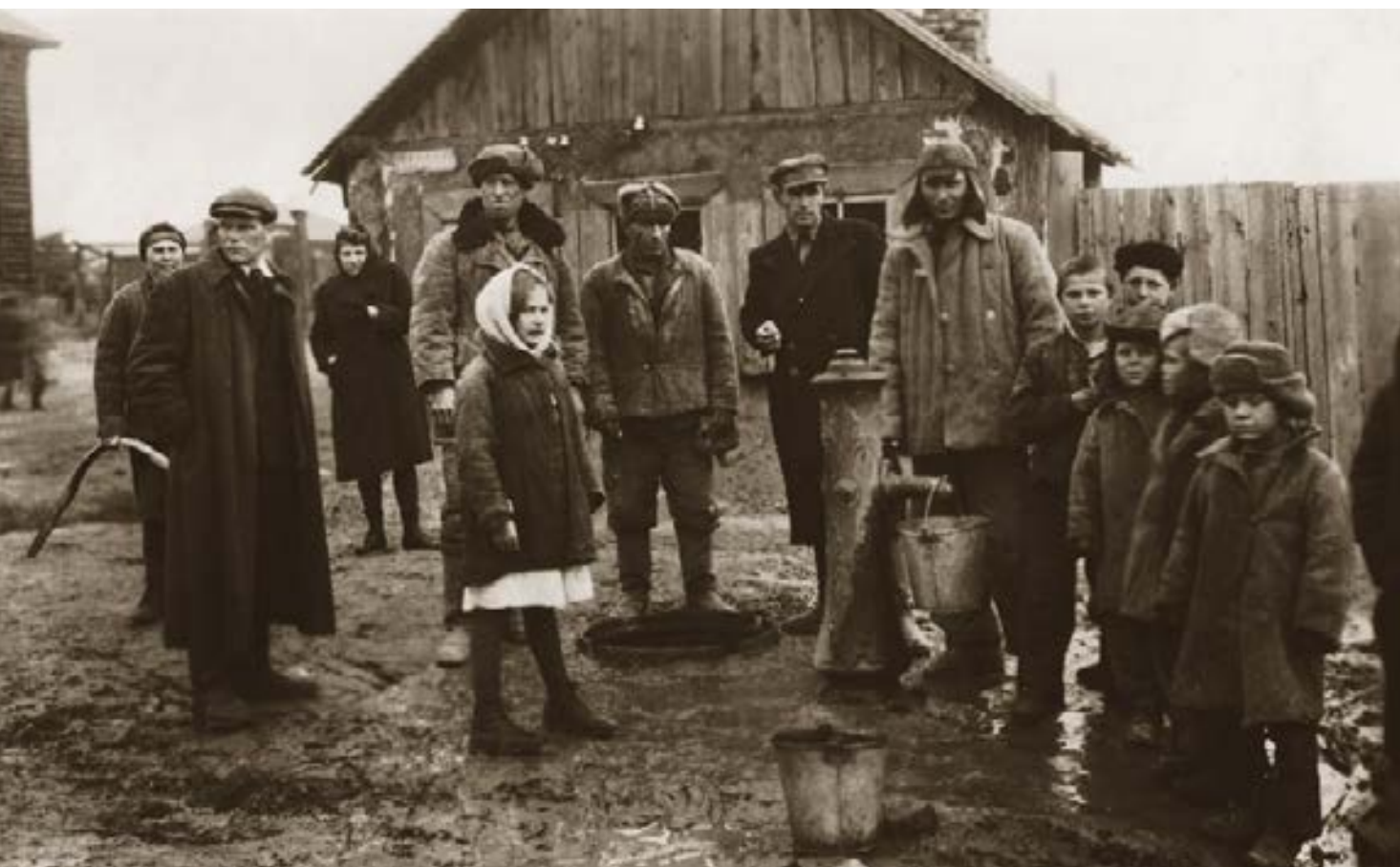
Запуск водопроводной колонки на улице Крайней
