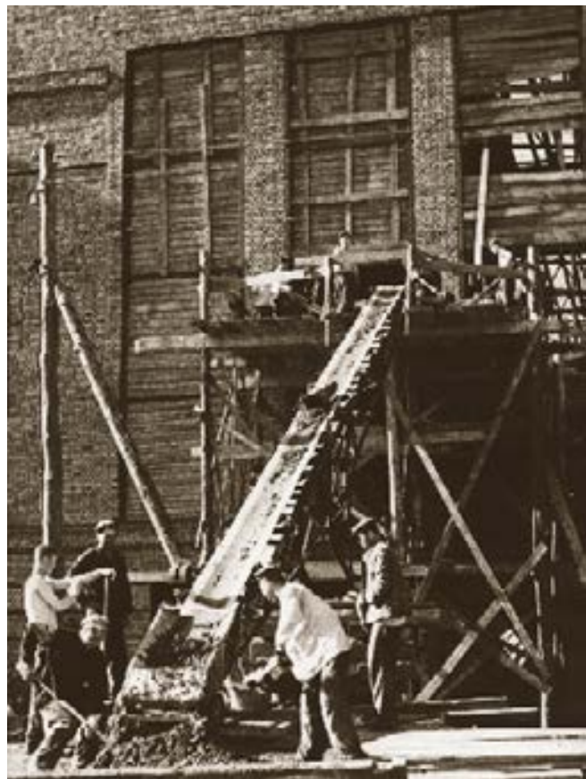
Строительство никелевого завода, 1942 г.
