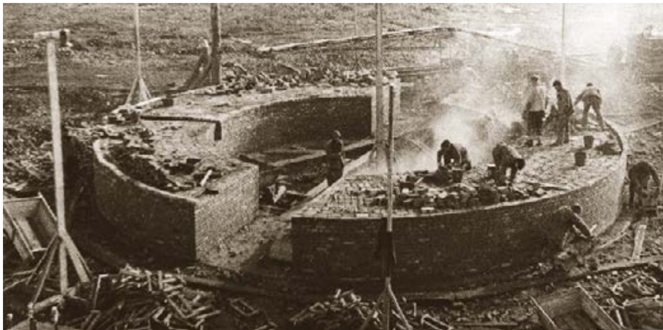
Строительство Большого металлургического завода в Норильске
