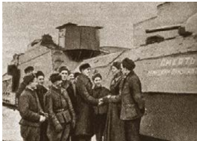
Построенный железнодорожниками бронепоезд перед отправкой на фронт
