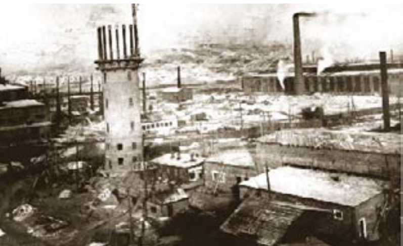
Строительство завода «Сибтяжмаш»
